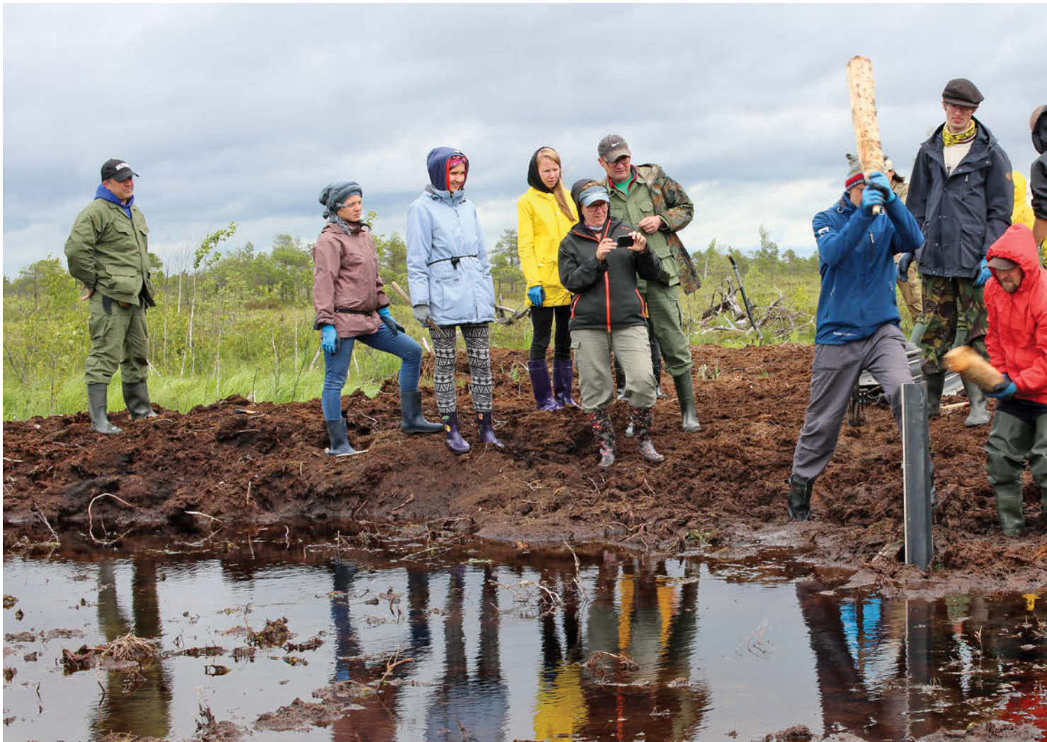
Talgulistel ei jätkunud vasaraid, et tõkeid turbasse rammida, seetõttu valmistasime kohapeal puitvasarad
